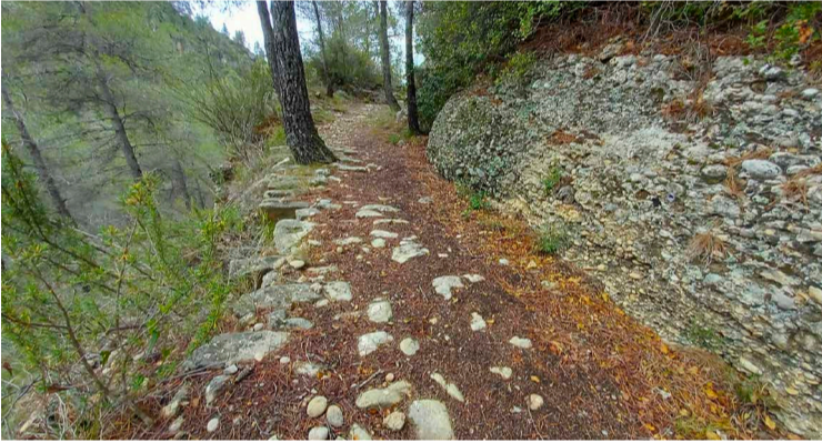
Camino empedrado que comunica Cabacés con La Bisbal.
