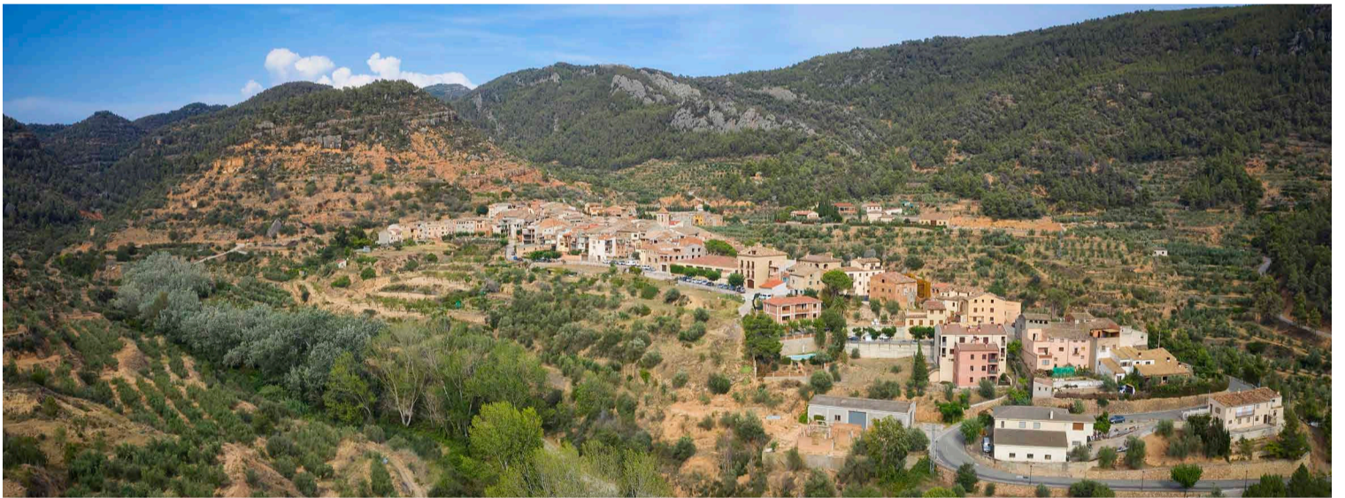
Vista de la alameda de Cabacés.
