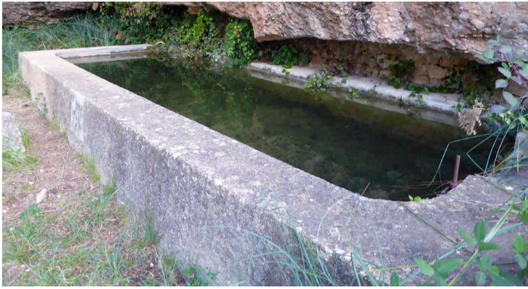
Balsa de El Aubelló, cerca de la fuente del mismo nombre.
