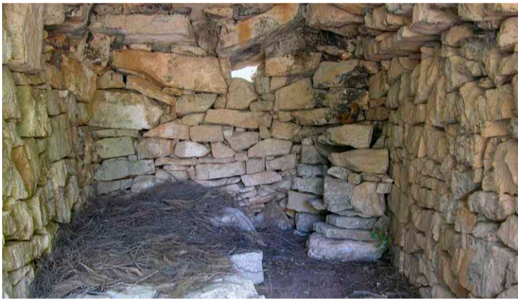
Interior d'una de les barraques de pedra de seca.
