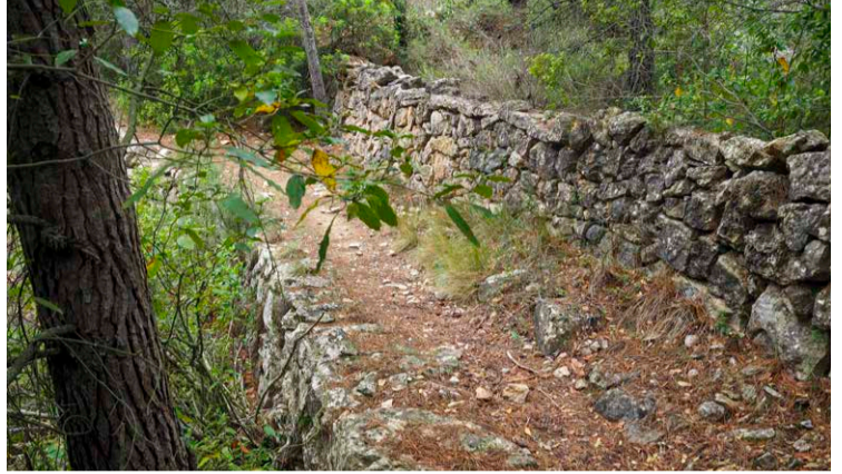
Camí de bast empedrat i consolidat amb murs de pedra seca.
