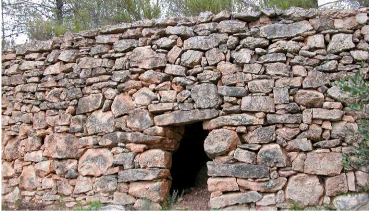
Mur amb aixopluc per guardar-hi les eines.
