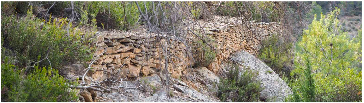
La piedra seca se utilizaba en la construcción de caminos.
